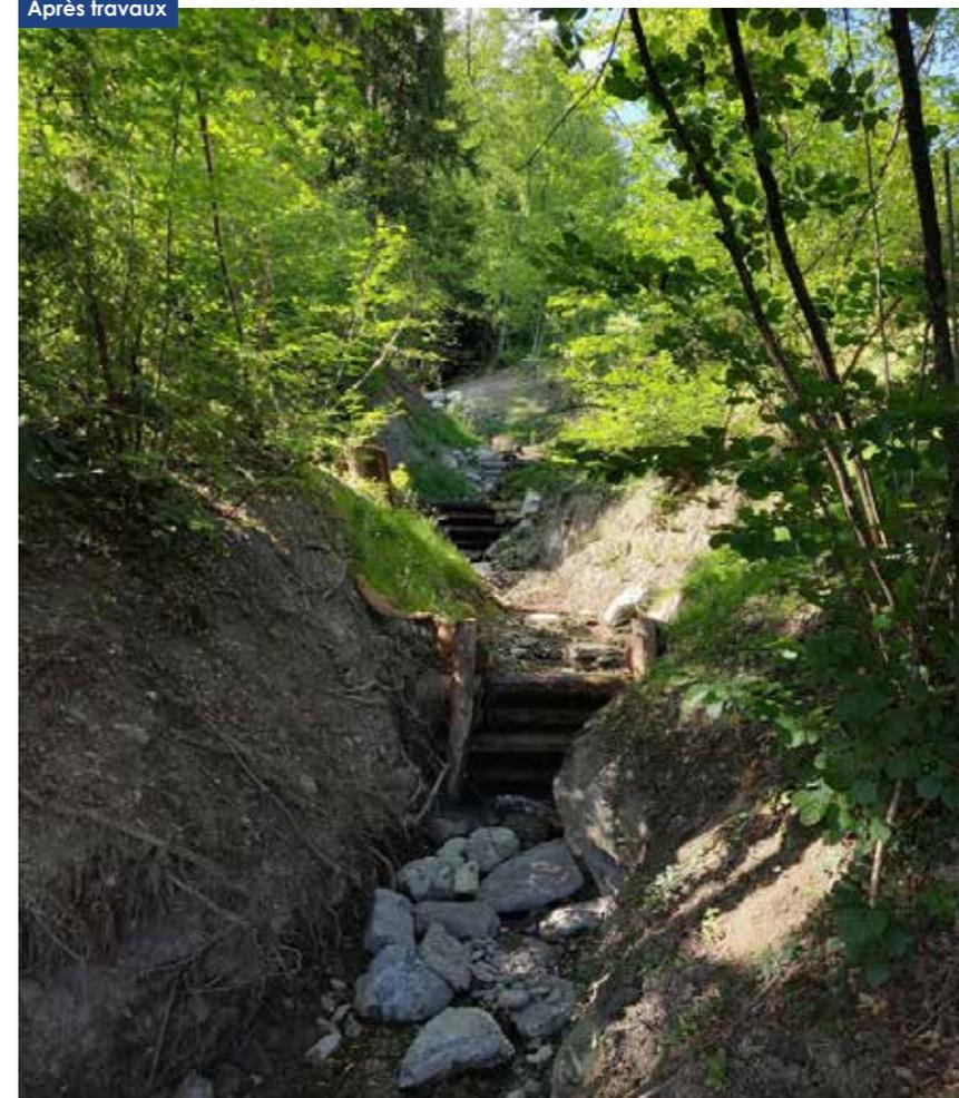
Les verrous « seuils brise-charge » aménagés dans le lit stabilisent le lit en constituant des marches qui abaissent la pente du lit entre chaque seuil, freinent la vitesse des écoulements et retiennent les matériaux.
