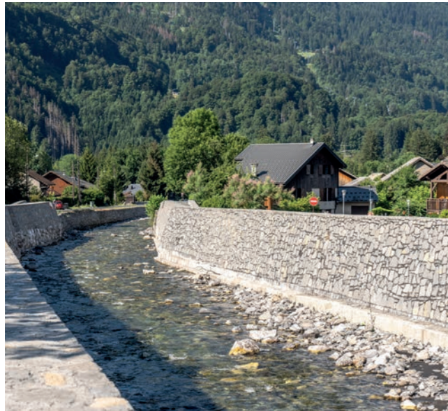
Digue du Clévieux après aménagement
