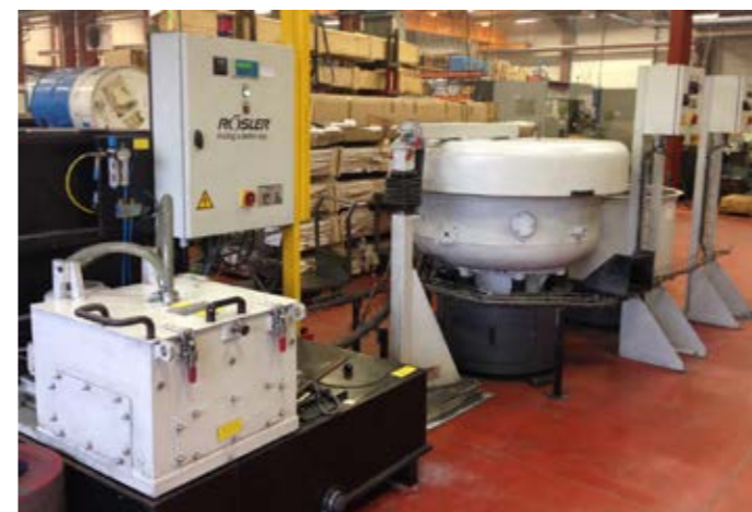
> Traitement des effluents de tribofinition dans une entreprise de décolletage à Vougy. Budget 22 000€ – Aide financière de 60%.
