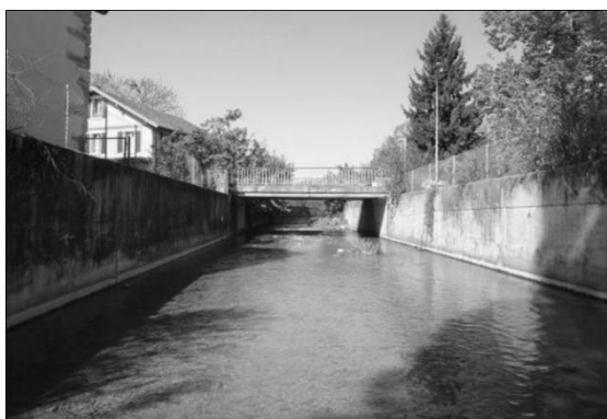
Pont de Cornières à Ville la Grand
