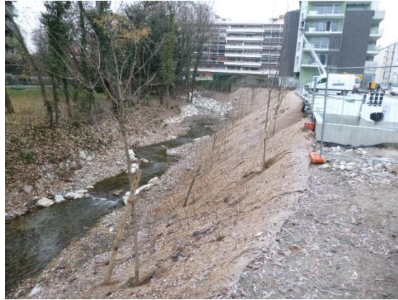
Exemple de travaux réalisés à l'opportunité sur les secteurs les plus contraints : Ilot Boulangerie Gaillard
