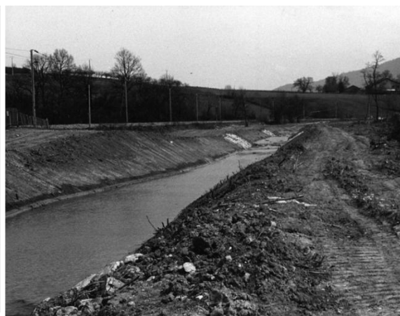
Travaux de rectification et de recalibrage Ville la Grand
