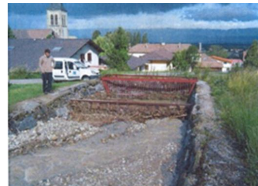
Le Boège avant sa traversée souterraine du chef-lieu de Saint-Cergues
