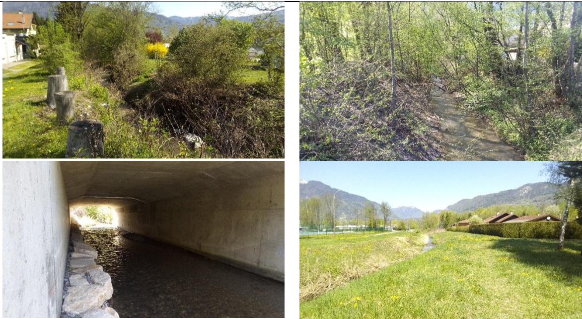
Photos du Nant de Marnaz, de l'amont vers l'aval (amont du Pont de l'Etoile, les Bosnées, les Bosnées, les Crevallats, banquette pieds secs sous l'autoroute, les Valignons)
