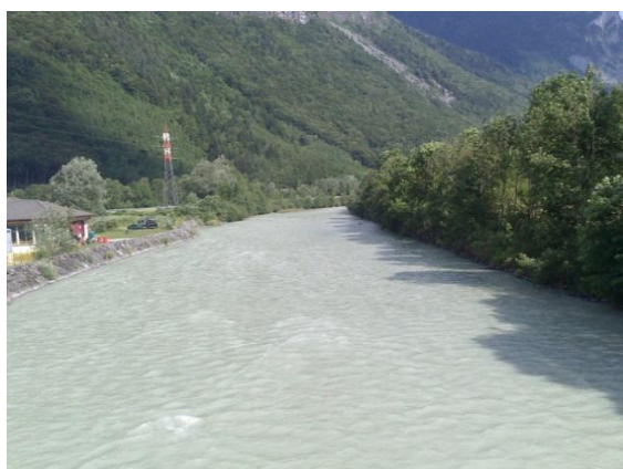
L'Arve à Magland (amont du pont Gravin) : chenal unique homogène (entre 20 et 40 m de bande active)
