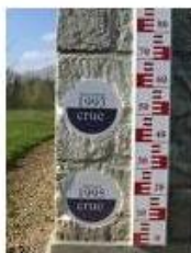
Pose de repères de crues
