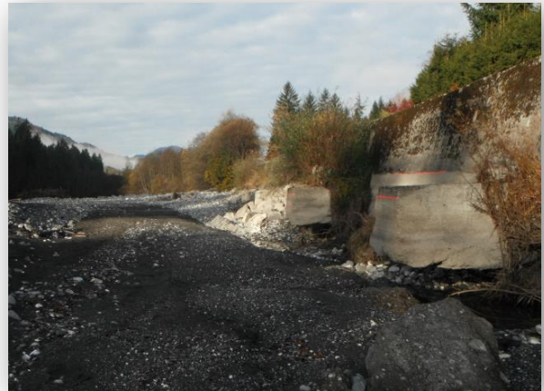
Figure 51 : Vue de la digue et des épis déchaussés
