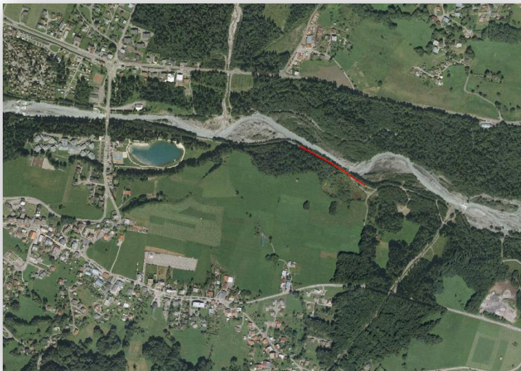
Figure 52 : Vue aérienne de la digue des Arcosses
