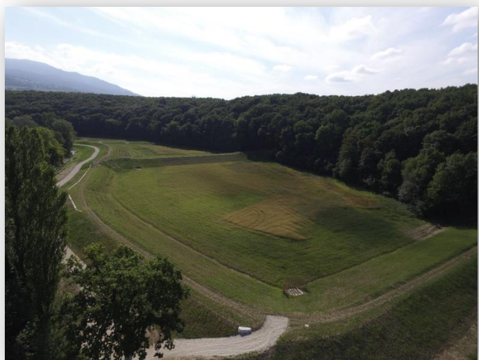
Figure 39 : Bassins de gestion des crues du Foron à Marsaz
