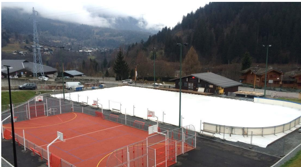
Figure 48 : Vue de la patinoire après travaux de déplacement
