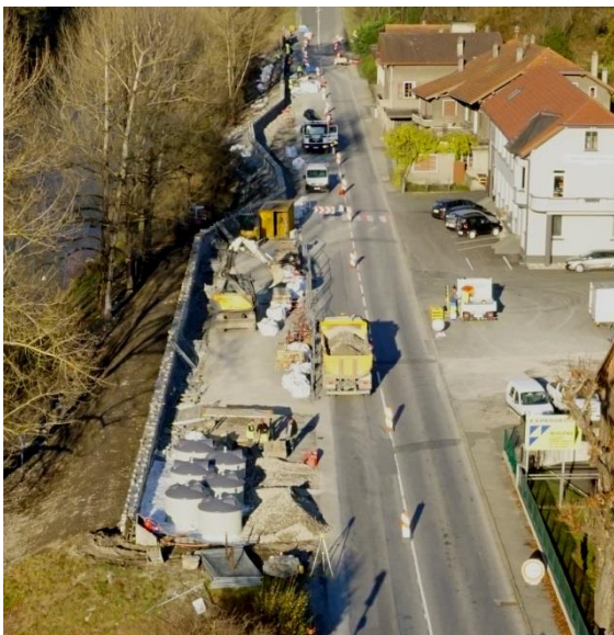
Figure 49 : Vue du mur de protection amont et du confortement des digues
